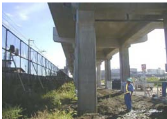
橋脚中性化防止
