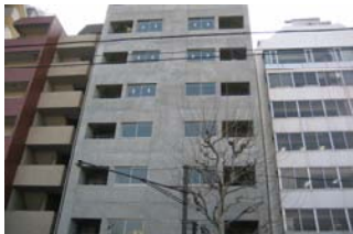
マンション外壁疎水材塗布
