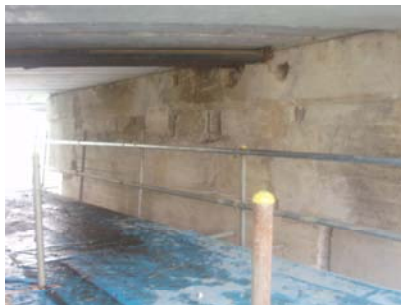
橋梁劣化防止
