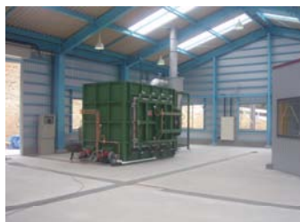
工場土間防塵
