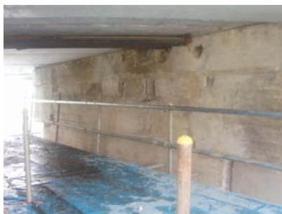
橋梁劣化防止
