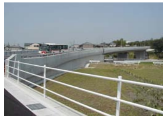
壁高欄劣化防止
