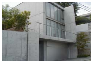
住宅外壁疎水材塗布
