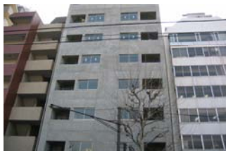
マンション外壁疎水材塗布
