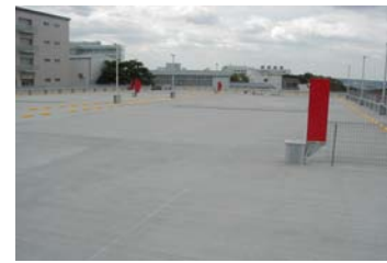
駐車場スラブ面強化(防塵)
