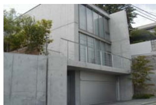
住宅外壁疎水材塗布
